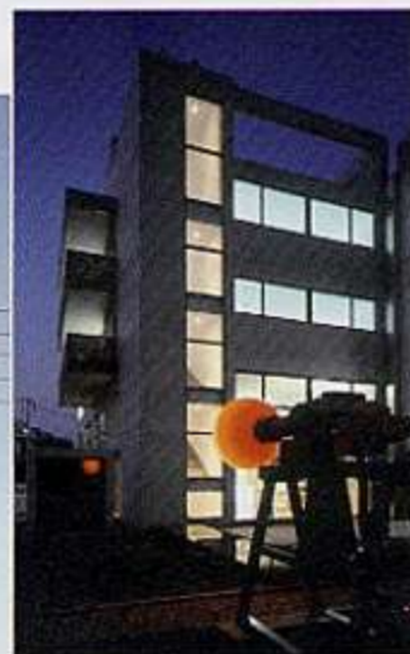
Vue arrière de l'atelier-boutique Workshop
